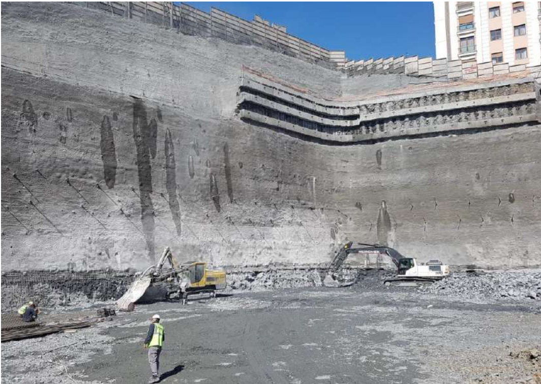
Şekil 12. Sahada Uygulanan İksa Çözümü
